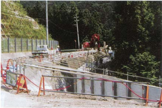
①着工前 (H鋼建込み)
