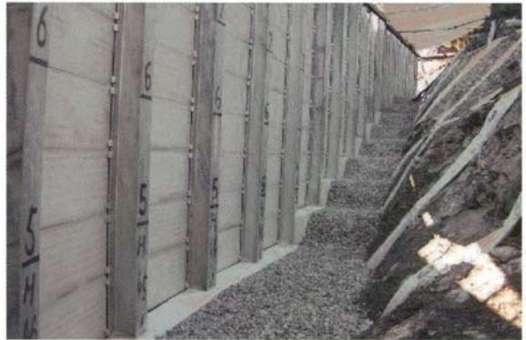
①着工前 (壁体施工)
