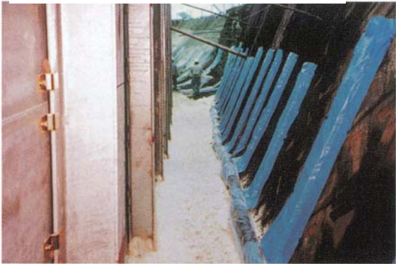
②排水材布設・ウレタンLH施工
