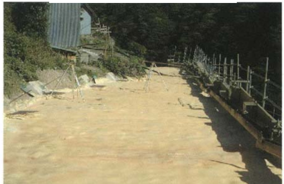
②ウレタンLH施工 (仕上げ)
