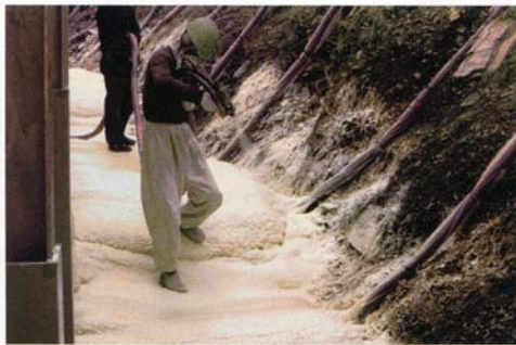
ウレタンLH施工
